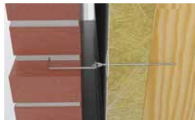
Montage av kramla i murverkets liggfog. Horizontalsnitt.
